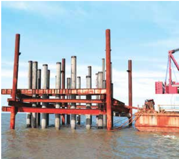
Thi công trụ điện gió Tân Thuận
