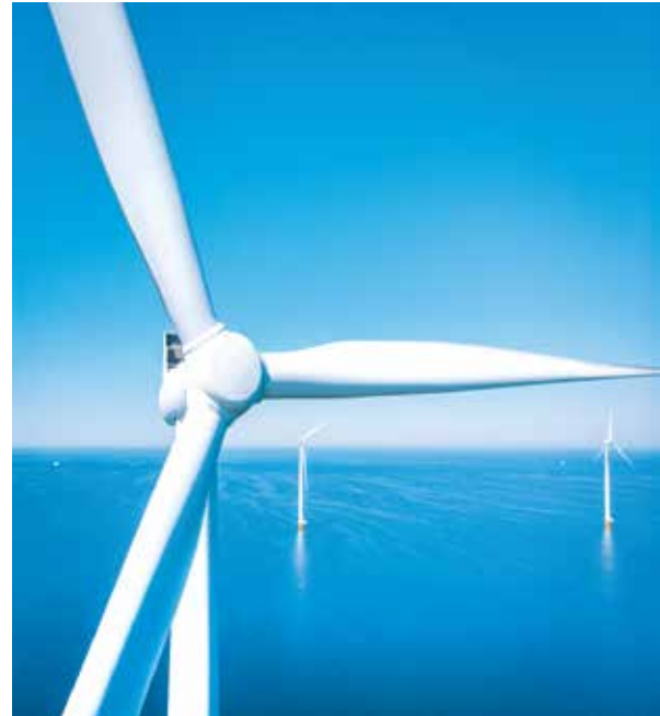
Mô tả Điện gió Tân Thuận
