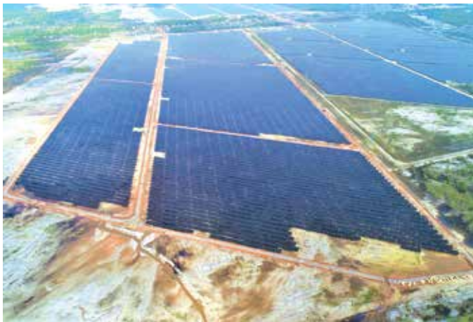
Điện mặt trời Gio Thành 1 (50MWp) - EPC
